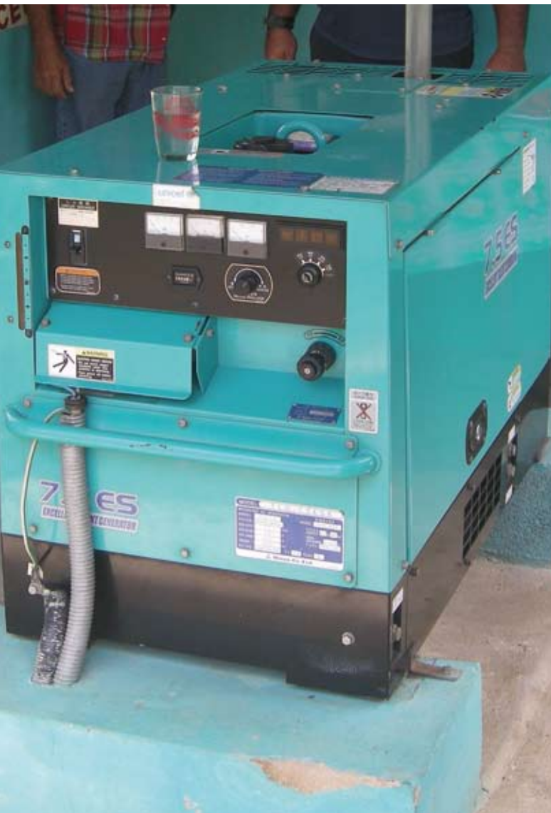
● Cuba, proyecto de aguas en Gibara
